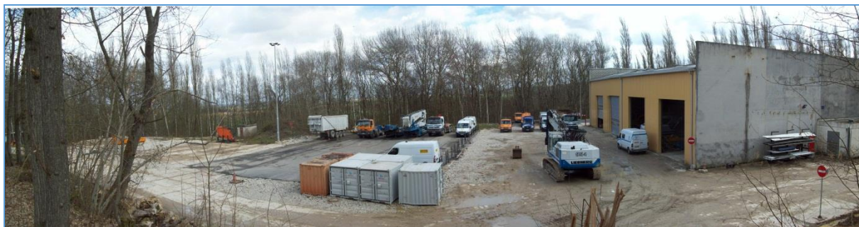
Photo 1 – Vue de l'atelier mécanique (Photo Colas IDFN)
