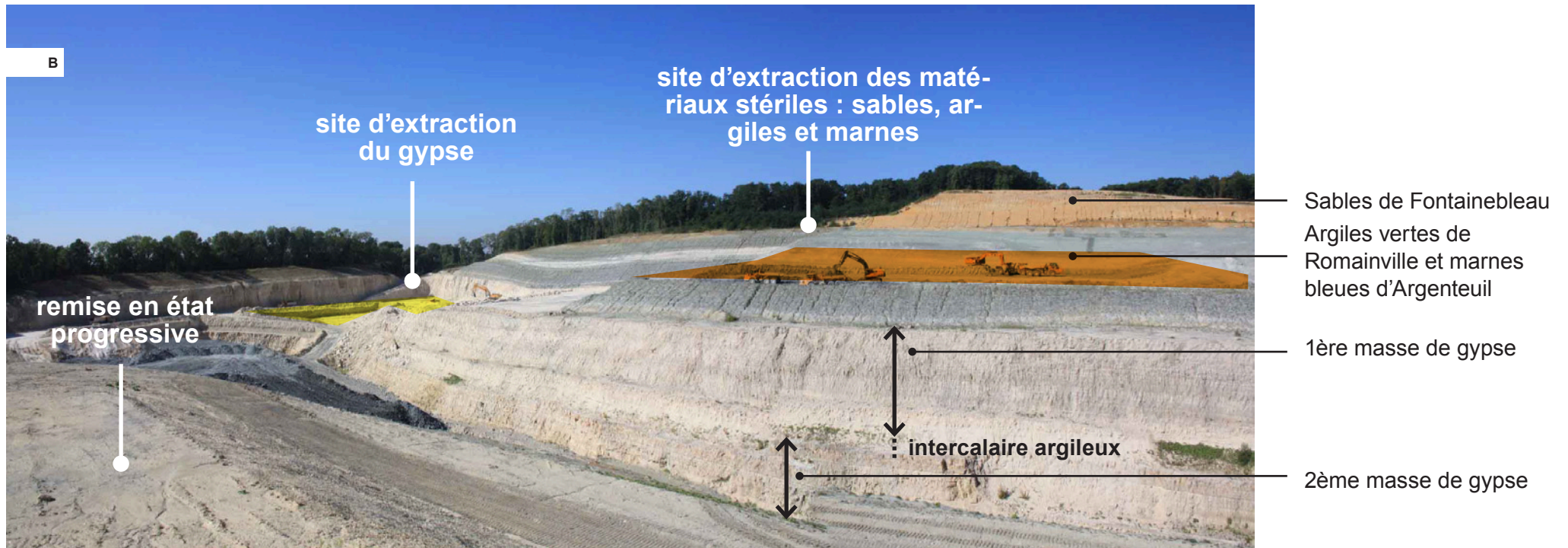
B | 3 ACTIONS SIMULTANÉES PENDANT L'EXPLOITATION : EXTRACTION DU GYPSE, EXTRACTION DES STÉRILES ARGILEUX ET SABLES, REMISE EN ÉTAT
